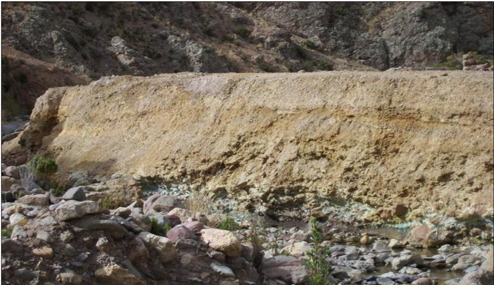
Figura 4. Desmonte y material lixiviado por acción de la lluvia. (Recolección propia, Luis Orbegoso).
