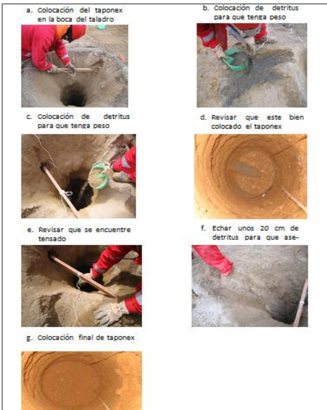
Figura 4.16: Procedimiento colocación de taponex Fuente: Elaboración propia
