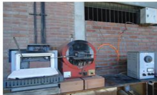
INSTALACION TOTAL ACTIVACION CON VAPOR DE AGUA
