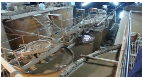
Figura 12 Tanques de agitación CIP
