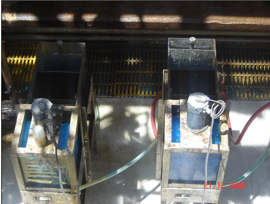
Figura 57. Vista superior de dos celdas de la Planta Piloto
