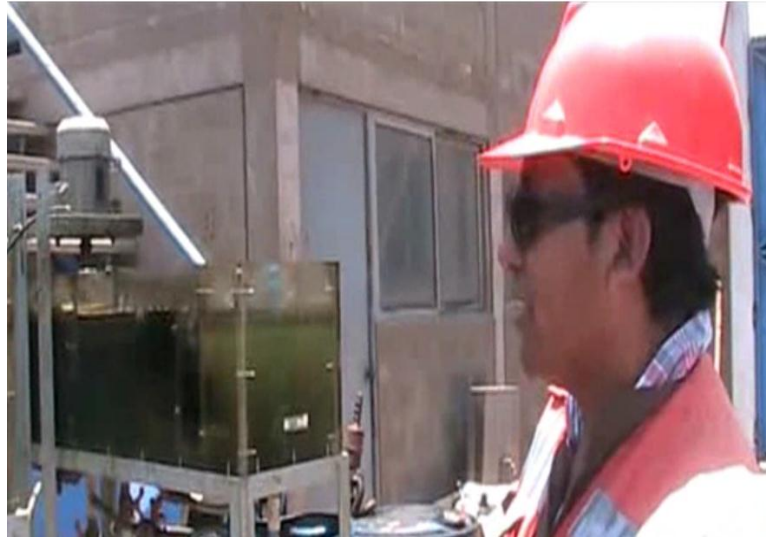
Figura 40. Vista de operación de la celda Fuente :Empresa South Service Engineers
