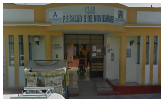
Puesto de Salud 05 de Noviembre
