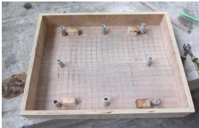
Figura 27. Encofrado de madera para prototipo
