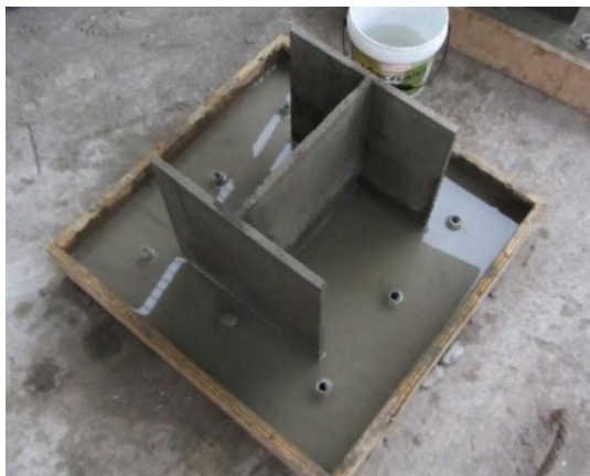
Figura 36. Muro H desencofrado.
