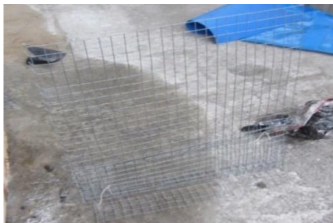
Figura 31. Presentación de la malla de acero del muro H a escala real.
