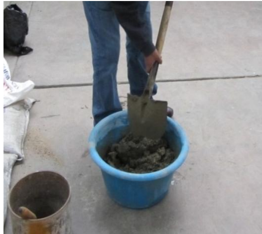
Figura 30. Mezcla de cemento – arena – agua para fabricar el prototipo
