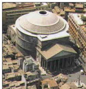
Figura 1. Vista aérea de la edificación Pantheon
