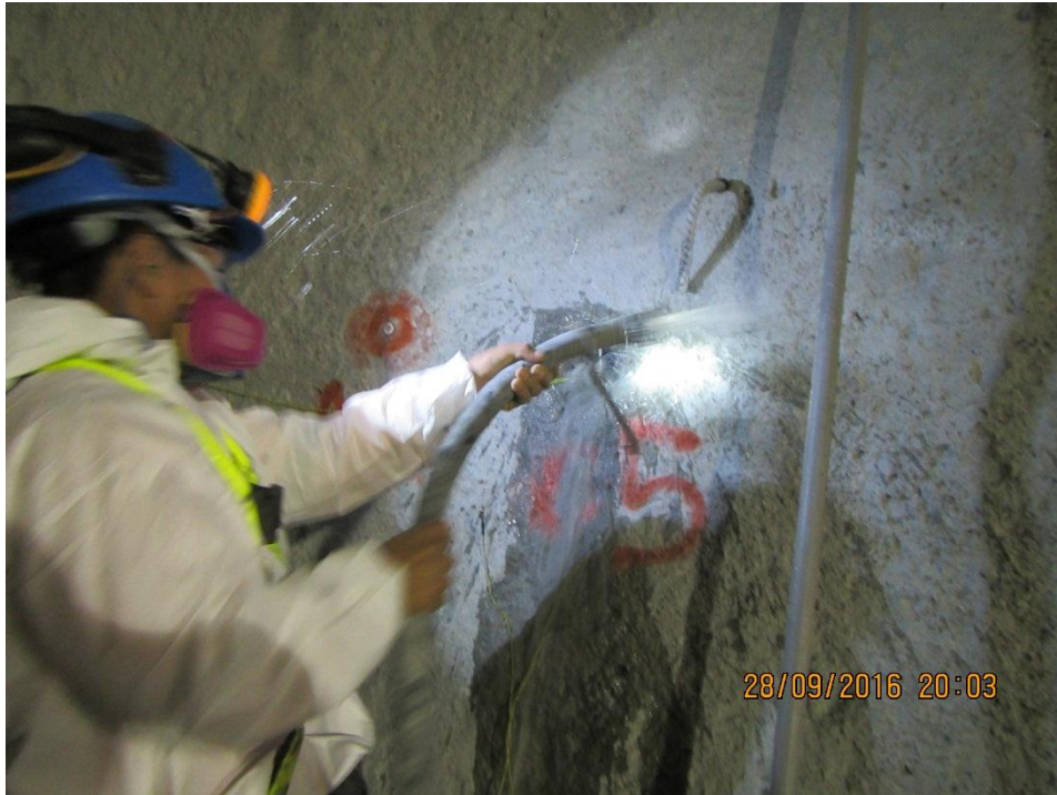
Foto 5: Preparación de la carga explosiva y apisonamiento del taladro de disparo con agua.
