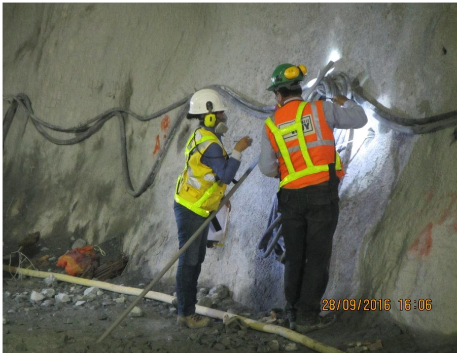
Foto 3: Medición de los Puntos de disparo en el lateral derecho del túnel Restitución
