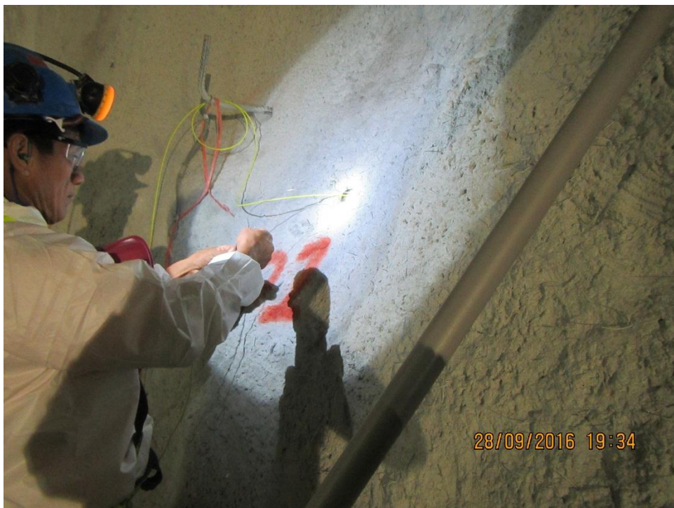
Foto 5: Preparación de la carga explosiva y apisonamiento del taladro de disparo con agua.
