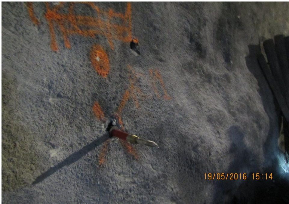
Foto 3: Ubicación del Receptor 1 (RCV1) en el lateral izquierdo del Túnel Restitución
