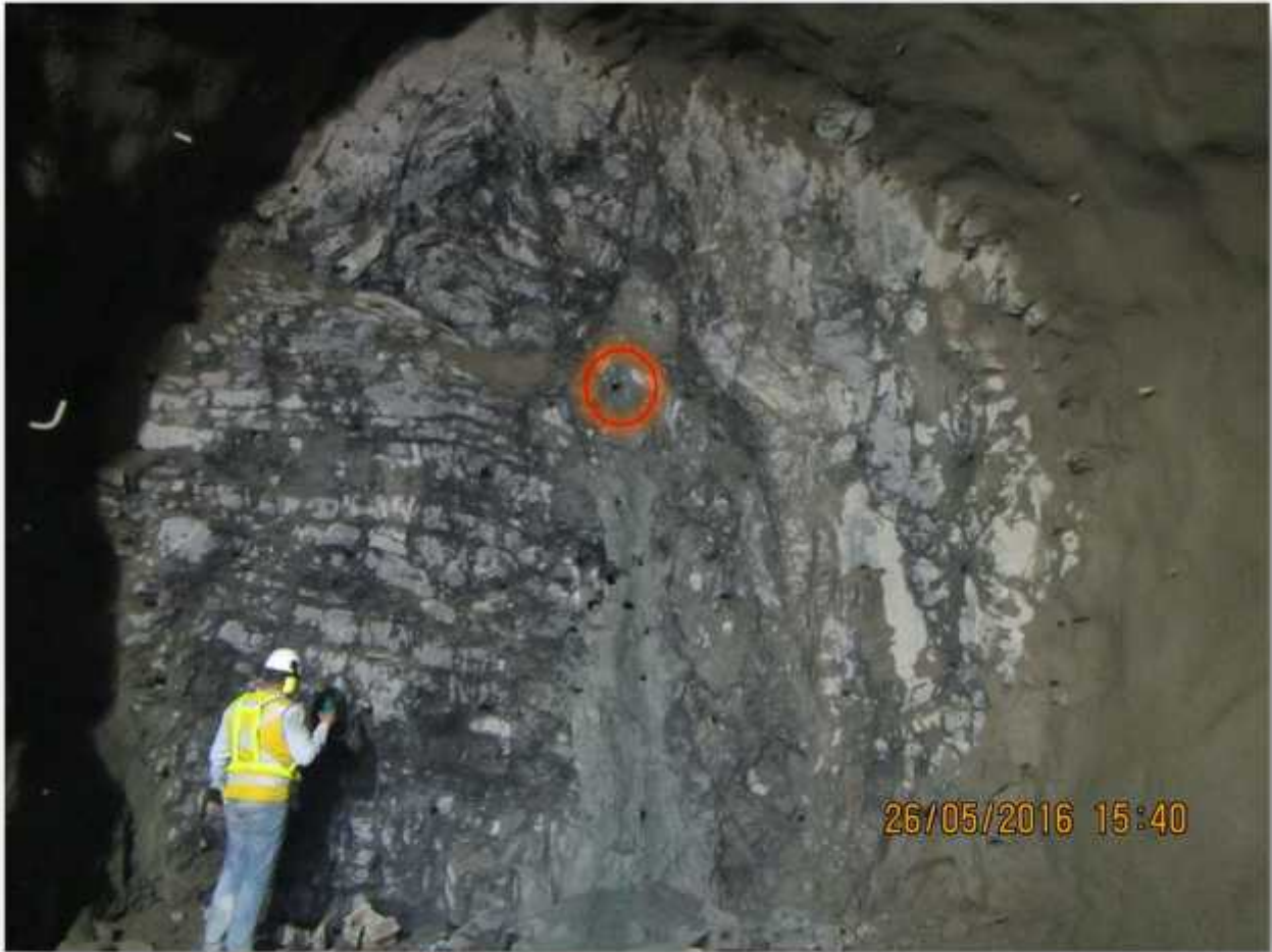
Imagen 1.- Ubicación del Sondeo Mecánico TR-1620 en el PK 1+158.90
