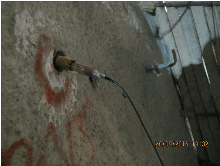
Foto 2: Ubicación del Receptor 3 (RCV3) en el hastial derecho del Túnel Restitución
