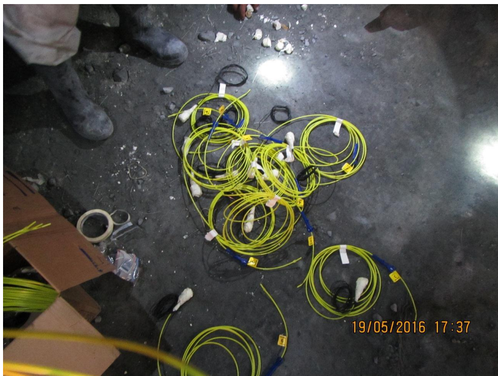
Foto 4: Preparación de la carga explosiva para la prueba del Tunnel Seismic Prediction (TSP)
