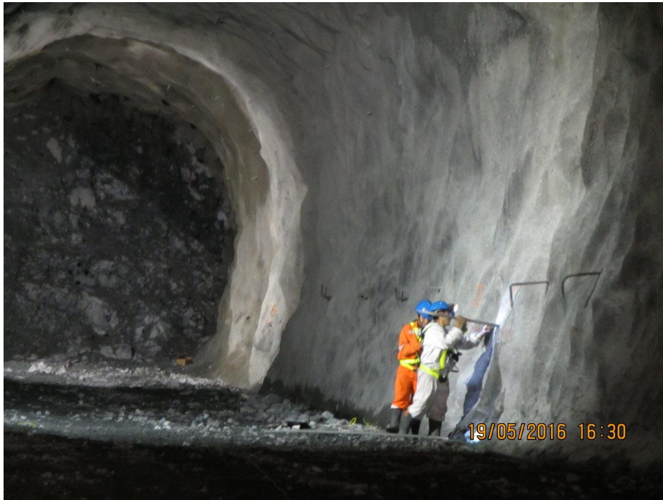
Foto 5: Apisonamiento del taladro de disparo con agua.
