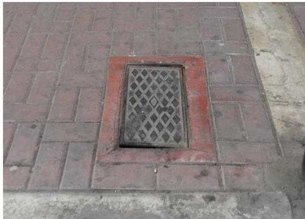
FIGURA 35. CAJA DE DESAGUE
