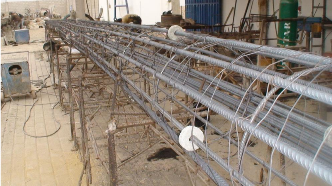
Figura 7. Construcción de armadura de acero de los postes.
