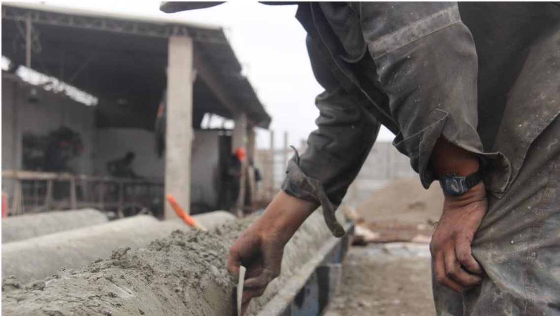
Figura 13. Resanado y fraguado de los postes.
