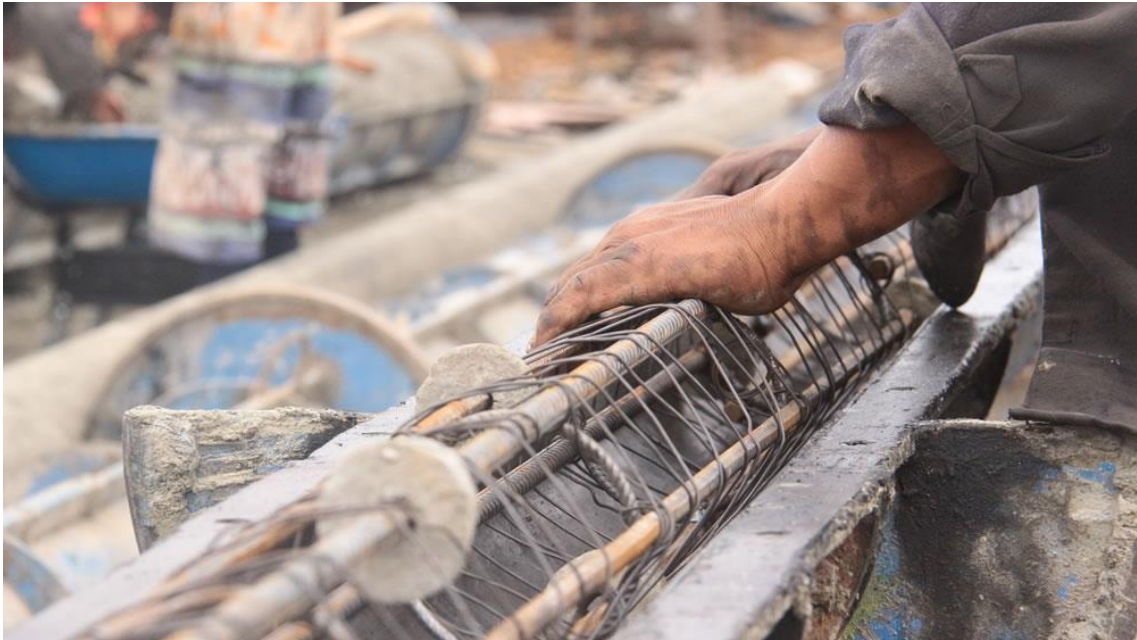
Figura 9. Instalación de la armadura de los postes en el molde.
