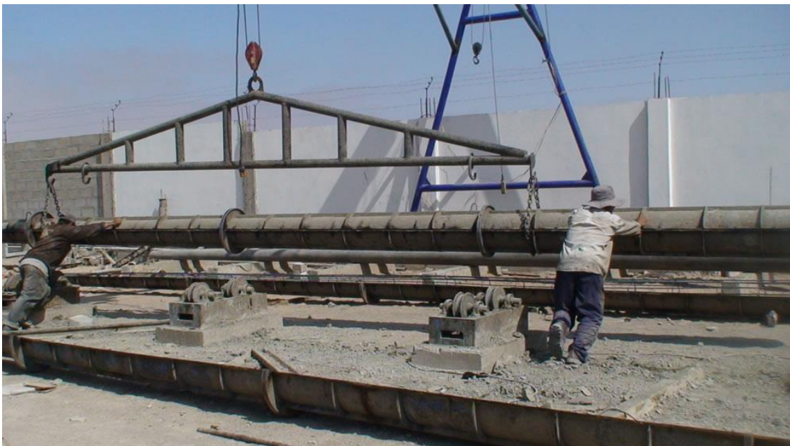
Figura 12. Traslado del poste.
