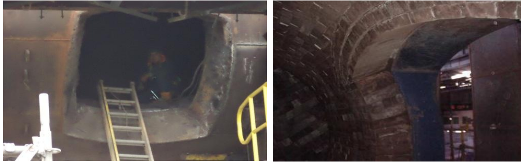
Figura 24. Mampostería refractaria del CPS zona de la boca
