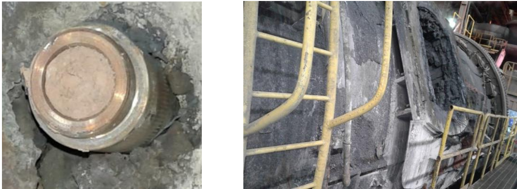
Figura 16. Zona tobera y reparación parcial del CPS N° 7
