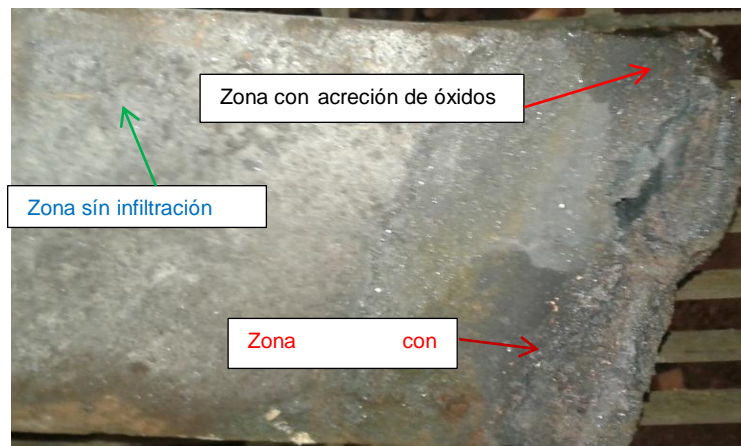
Figura 31. Infiltración del ladrillo refractario
