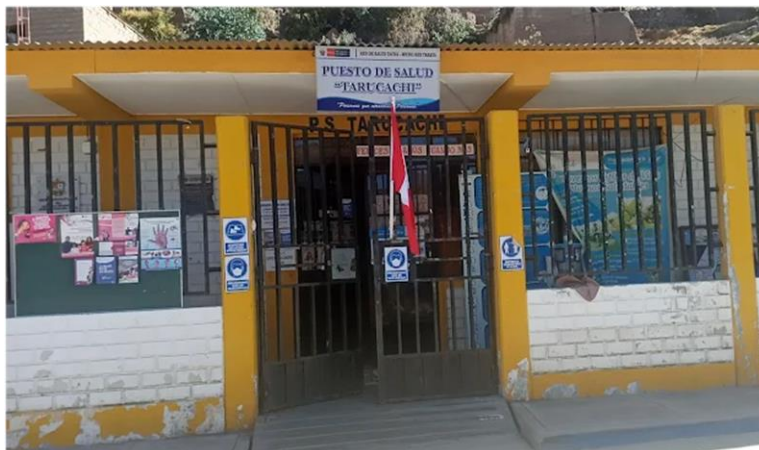
Figura 1. Vista frontal del Puesto de Salud Tarucachi. Establecimiento de primer nivel ubicado en la provincia de Tarata, región Tacna.
