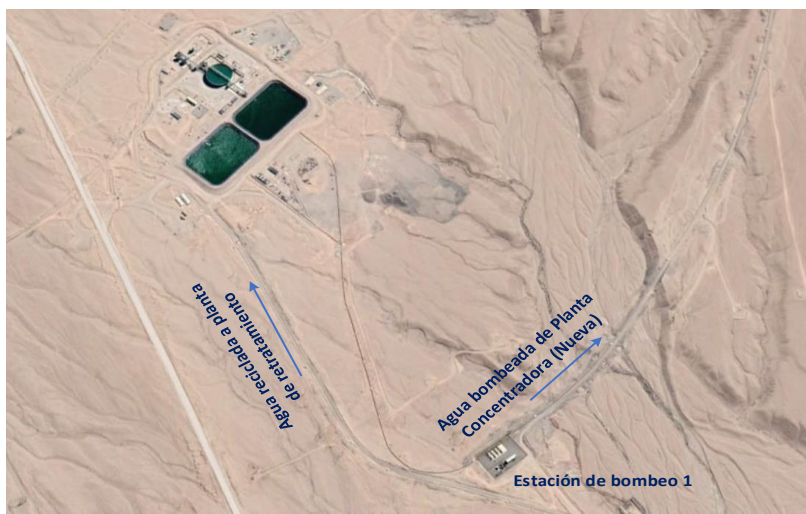
Planta de retratamiento del agua reciclada
