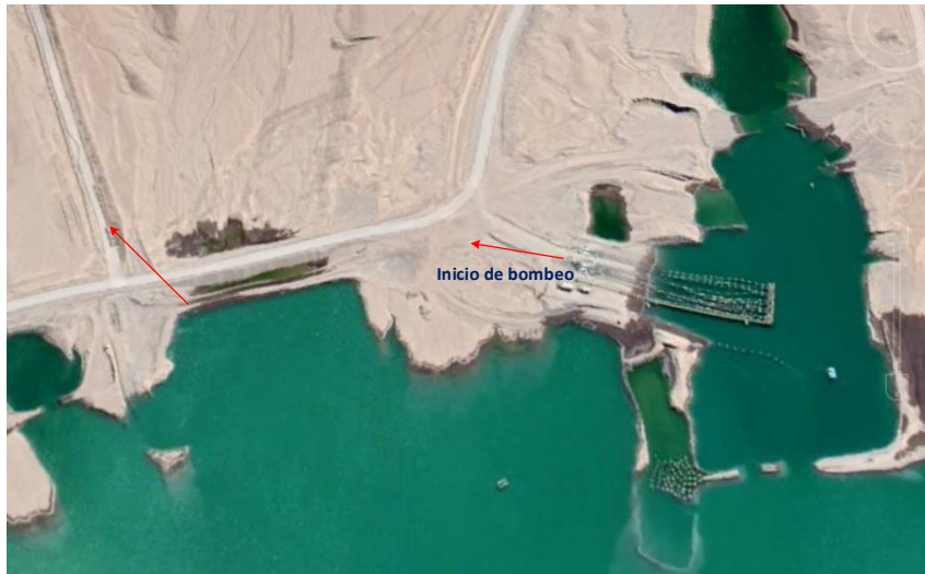
Zona de bombeo de la relavera Quebrada Honda
