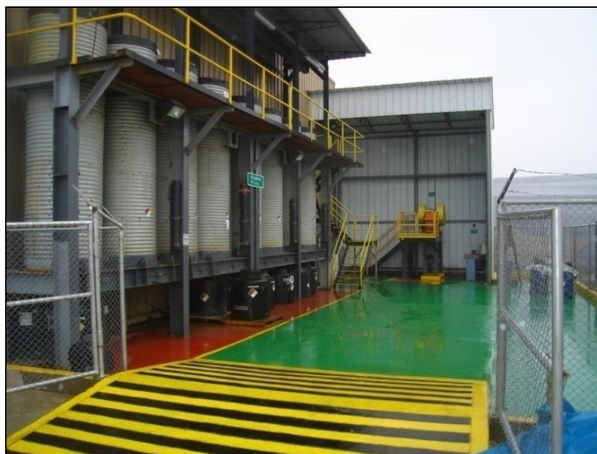
Foto 6: Columnas de 3 m de altura.
