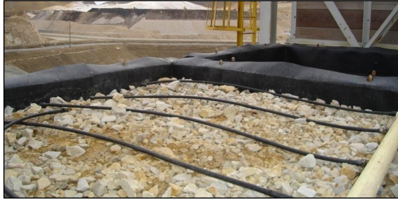
Foto 7: Riego en columnas de 10 m de altura
