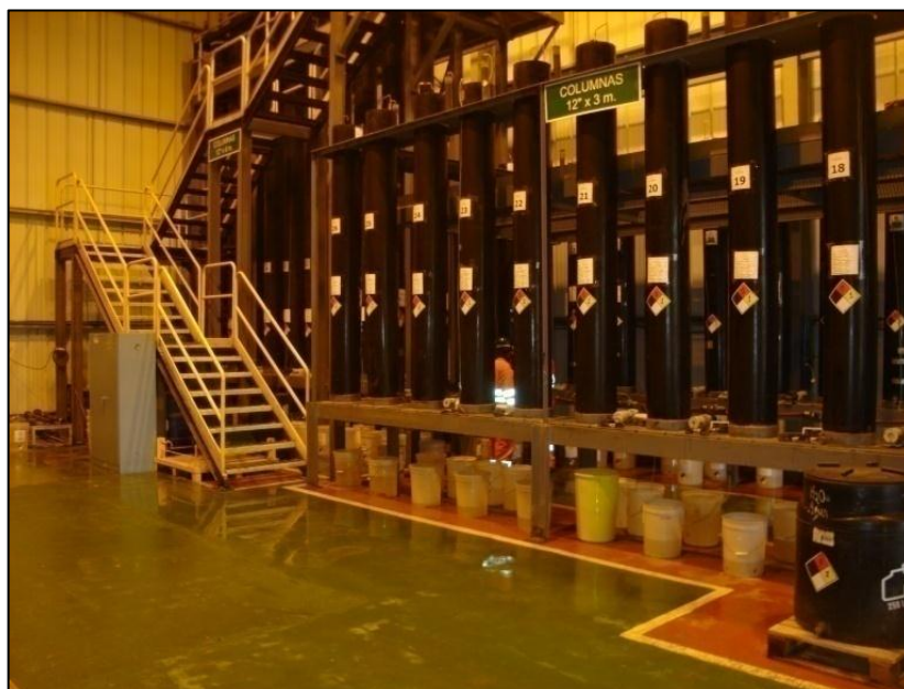
Foto 5: Columnas de 3 m de altura por 12 pulg. diámetro.
