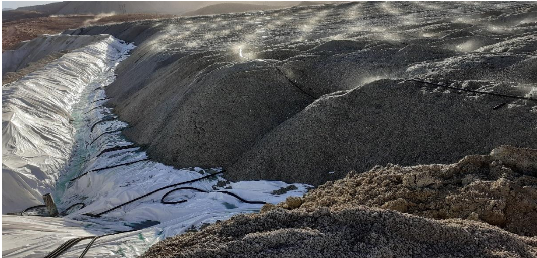
Figura 3. Transporte de soluciones por canaletas Fuente: Surco Álvarez, Marco (2012)
