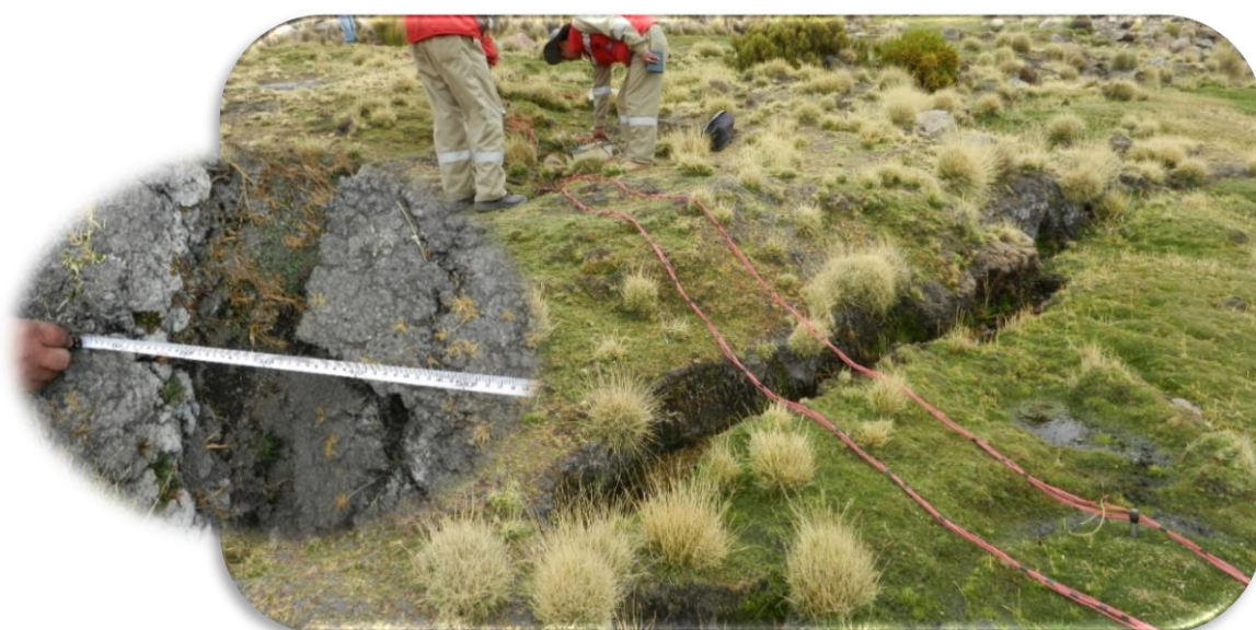
Foto 7. Sector2: Grietas de tensión en la zona de bofedal, en forma longitudinal al eje de la línea de conducción y abertura de hasta 50 cm y longitud de 24 m. Elaboración propia.
