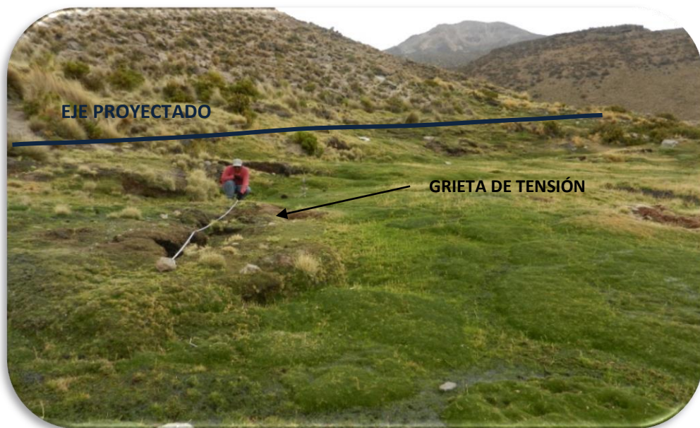
Foto 4. Sector1: Bofedal por donde atravesará la línea de conducción, grietas de tensión de 10 m de longitud. Elaboración propia.
