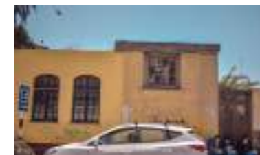
Edificación antigua hecha de adobe y con interiores de quincha
