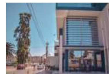
Edificación nueva construida de concreto armado
