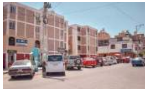
Zona Residencial: Estado de Edificación Regular
