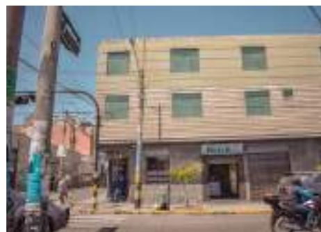
Viviendas próximas: Estado de Edif. Bueno
