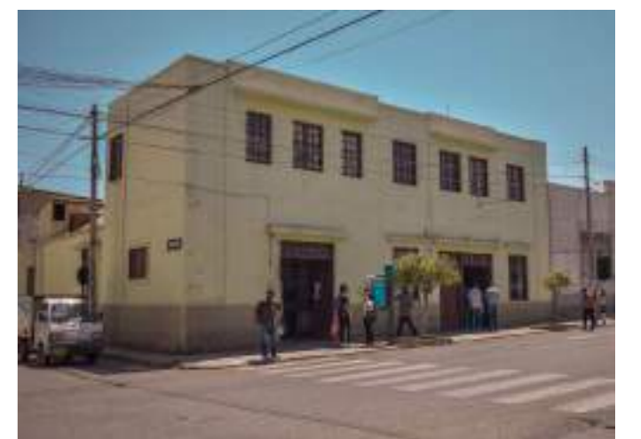
Edificación hecha de adobe
