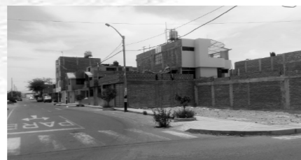
Imagen: TACNA-vivienda de Ladrillo. Fuente: Elaboración propia.
